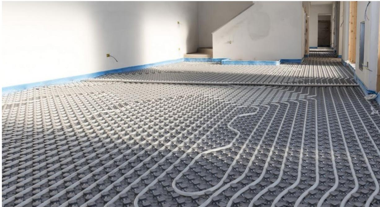
*“ LES TUYAUX DE DISTRIBUTION DE L'INSTALLATION DE CHAUFFAGE SONT EN PE SOUS GAINÉ DE PROTECTION. ILS SONT ENCASTRÉS DANS LES MURS ET DANS LES CHAPES ET MUNIS DES ISOLATIONS NÉCESSAIRES. “*
