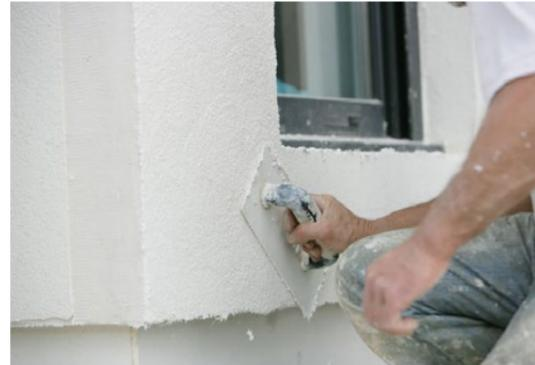
*LES MURS EXTÉRIEURS SONT REVÊTUS D'UN ENDUIT D'ARMATURE ET UN ENDUIT FINAL LIMOUSIN À BASE DE SILICATE RESP. DE SILICONE."*
